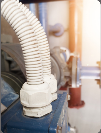
Сальники зажимают кабель, исключая его выдергивание.
